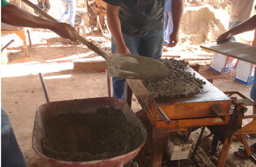
Material já misturado na betoneira e levado a maquina de pavers para da o formato dos pavers.
