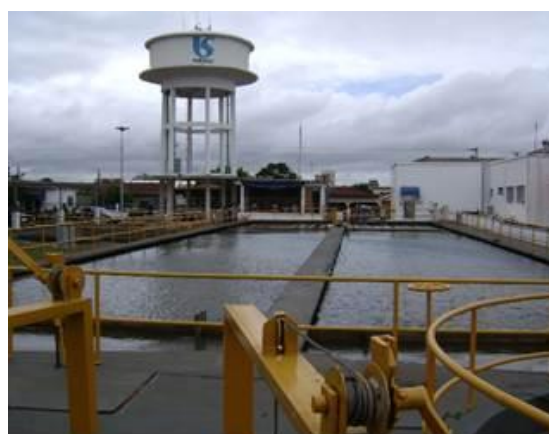
Figura 3 - Estação de Tratamento de Água (ETA).
