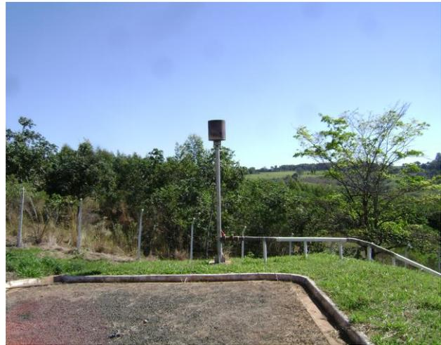
Figura 04: Flare para queima e transformação de metano em dióxido de carbono na ETE de Echaporã.
