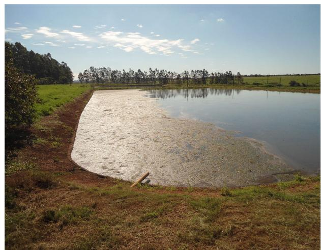
Figura 03: Lagoa facultativa de maturação para tratamento de esgoto de Cândido Mota.
